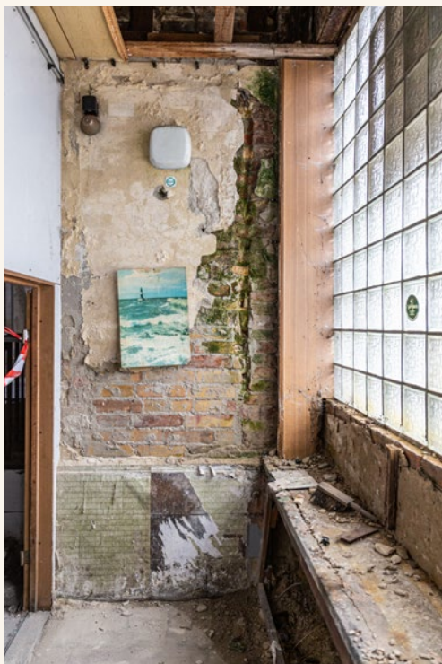
FOTO: Eingangsbereich mit Kassenschalter vor der Sanierung, 2023
