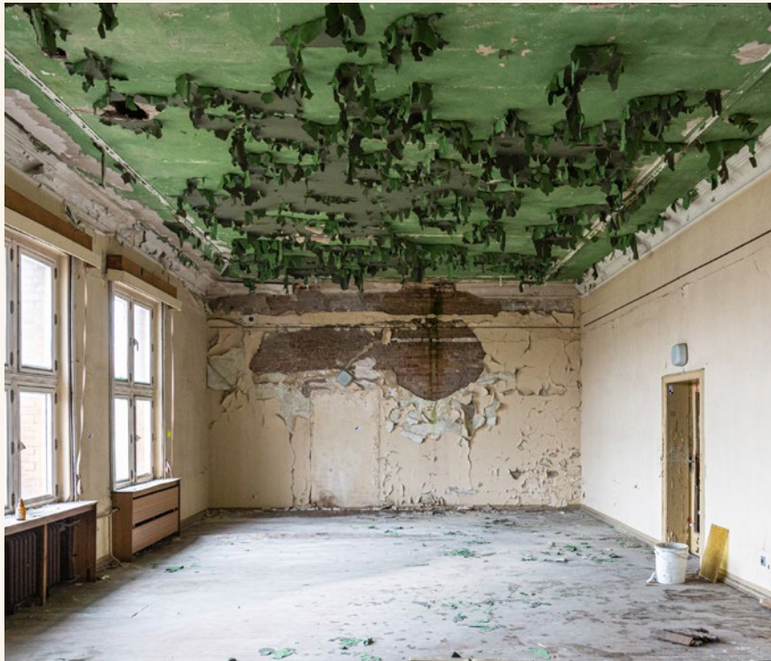
FOTO: Nebenraum vor der Sanierung, 2023
